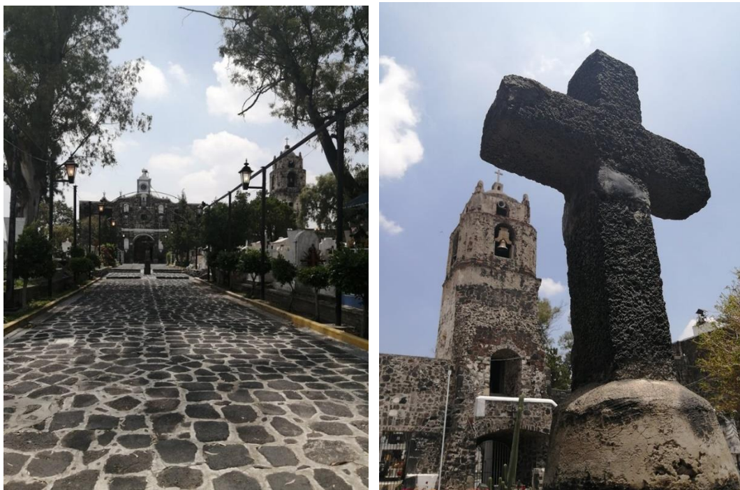
Imagen 4 y 5. Templo y ex-convento de San Andrés Apóstol de Mixquic, Tláhuac (S.XVI), construcción a cargo de la Orden Agustina. Edificio declarado monumento histórico en 1932. Alberga piezas arqueológicas pertenecientes a las culturas Tolteca y Teotihuacana, Fotografía tomada de dos distintos ángulos en junio de 2020.
